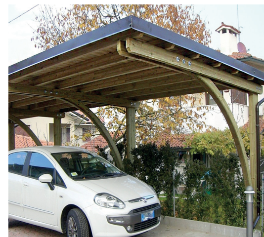
tettoia a sbalzo
